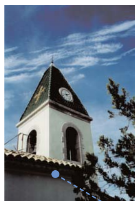
Clocher de Notre-Dame des Ormeaux à La Garde après restauration
